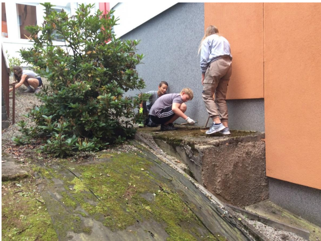
Začínáme – práce kolem školy
